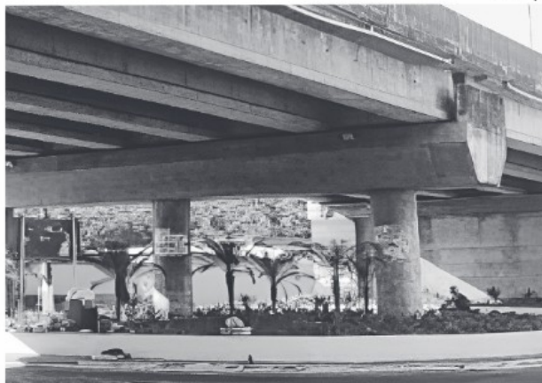
Embaixo do viaduto localizado no bairro de Jacarecica, obras impediram permanência de moradores de rua
